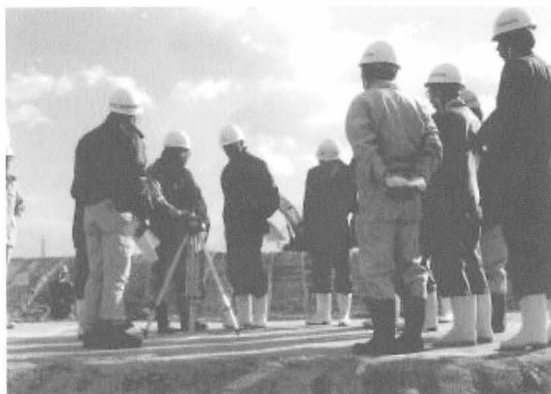
写真-4.1 衝撃加速度測定器（キャスポル）による測定状況
