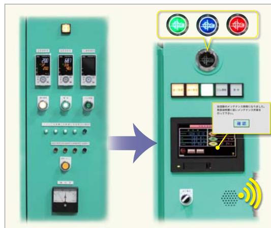
タッチパネルにより直感的な操作が可能になり、音声機能も加わって、メンテナンス時期・操作アシスト・トラブル発生を、画面と音声でお知らせします。また、運転ランプ色で装置状況が分かりやすくなっています。
